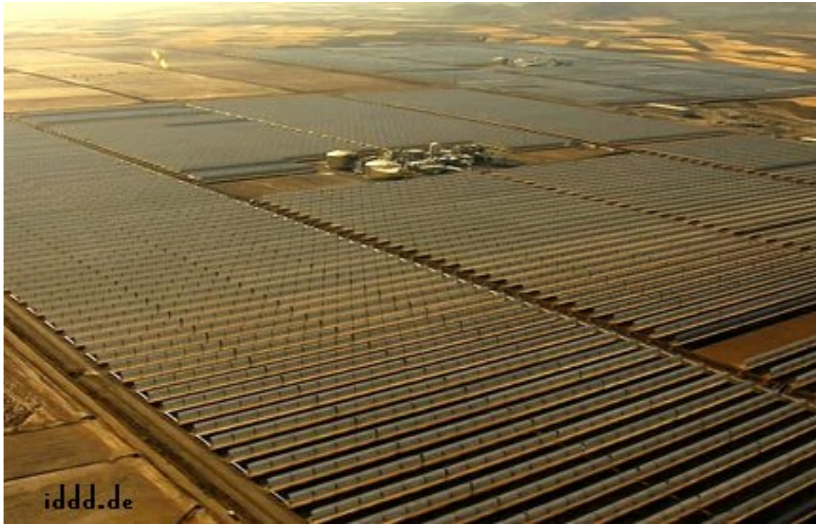
Elektrownia słoneczna w Oujda, Maroko
